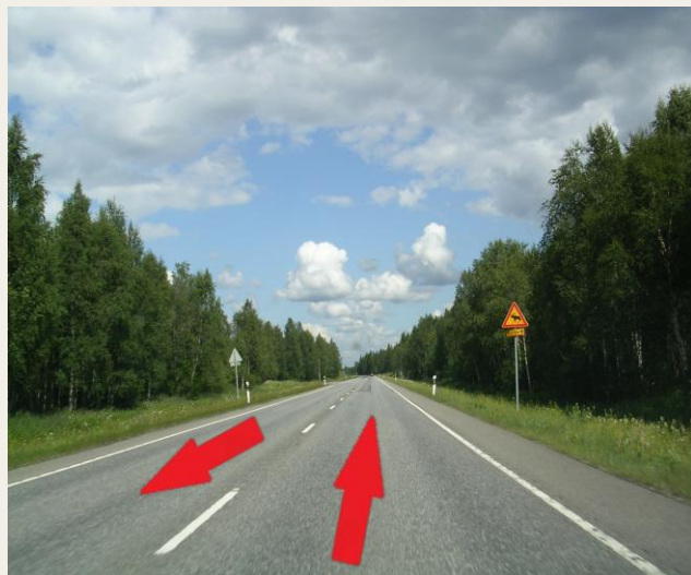
Autovía si barrera central
